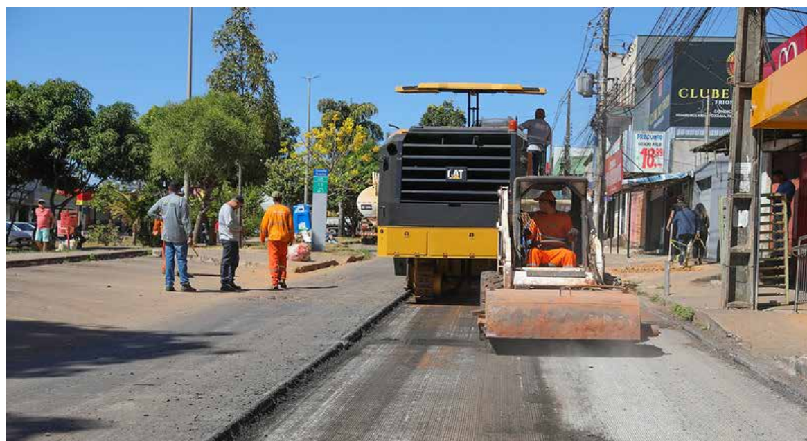
A Avenida Brasília, em Arni-queira, passa por obras de manutenção, que incluem troca do asfalto e intervenções na iluminação pública
